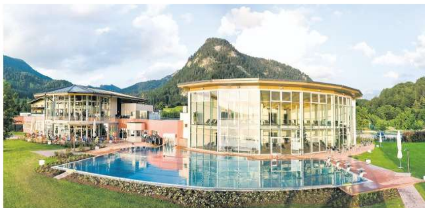
Das Fuschlseebad wird im Herbst um einen Wellnessbereich erweitert. Auch ein Kiosk wird gebaut.
