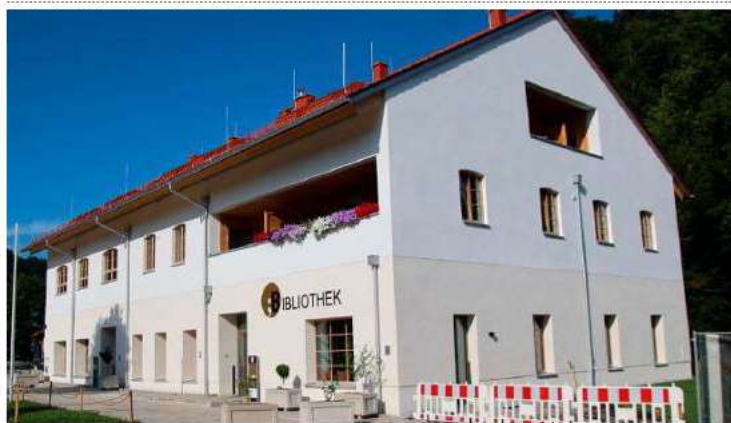
Das historische Schaberhaus wurde umgebaut und beherbergt Kindergarten, Bibliothek sowie auch Wohnungen für Senioren.
