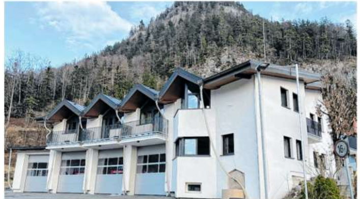
Die Arbeiten sollen im März beendet sein.
